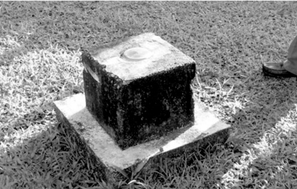
Contoh Pilar/titik kontrol kehutanan dalam kondisi baik (N 07063)
